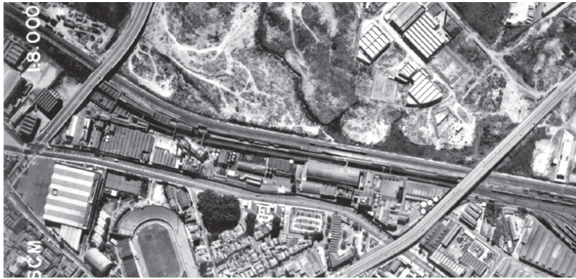
Figura 8 - Complexo das IRFM na Água Branca antes da demolição. Fonte: Arquivo Casa das Caldeiras.
