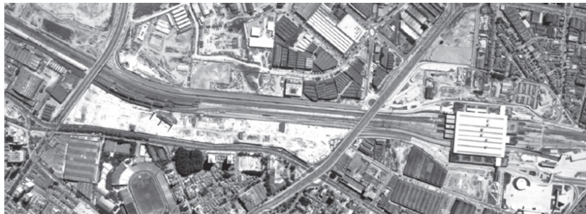
Figura 9 - Complexo das IRFM na Água Branca depois da demolição. Fonte: Arquivo Casa das Caldeiras.
