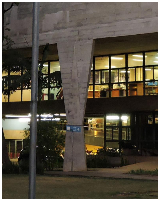
Figura 11 – Detalhe do pilar em forma de triângulo invertido que sustenta a caixa de concreto. Fonte: Samantha Palma (2016).
