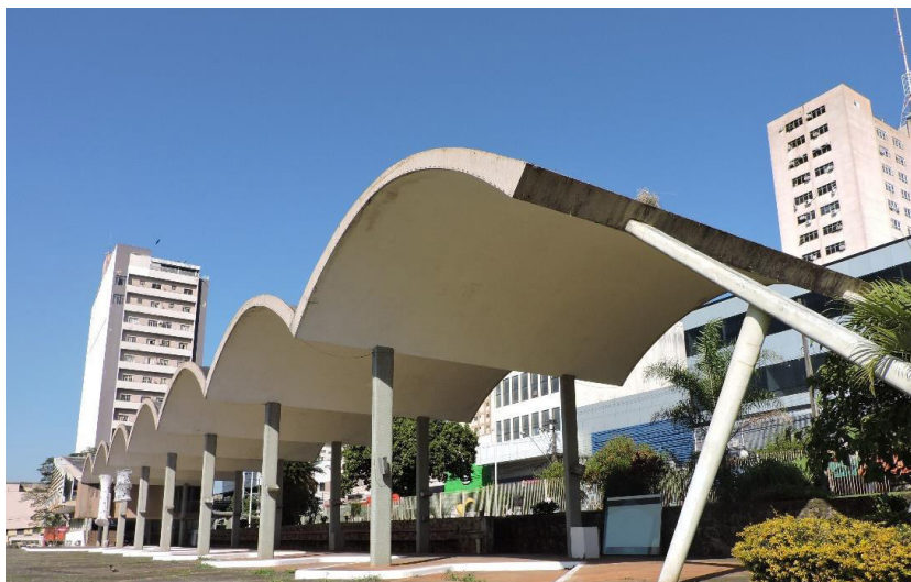
Figura 7 – Detalhe das cascas de concreto da marquise. Fonte: Samantha Palma (2016)
