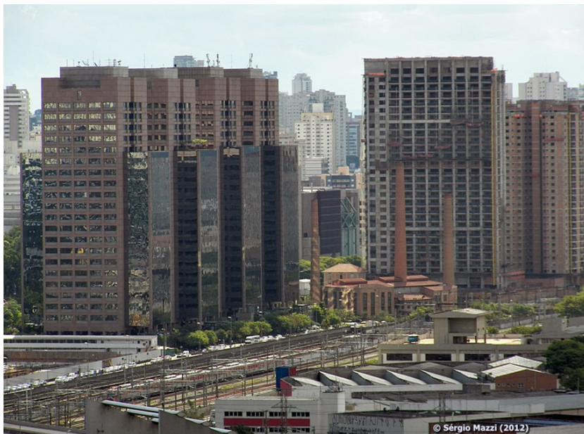
Figura 10 - Casa das Caldeiras e os empreendimentos construídos no terreno das antigas IRFM. Fonte: Mazzi, S. 2012. < http://www.skyscrapercity.com/showthread.php?t=151447&page=104 > Acesso em agosto de 2016.
