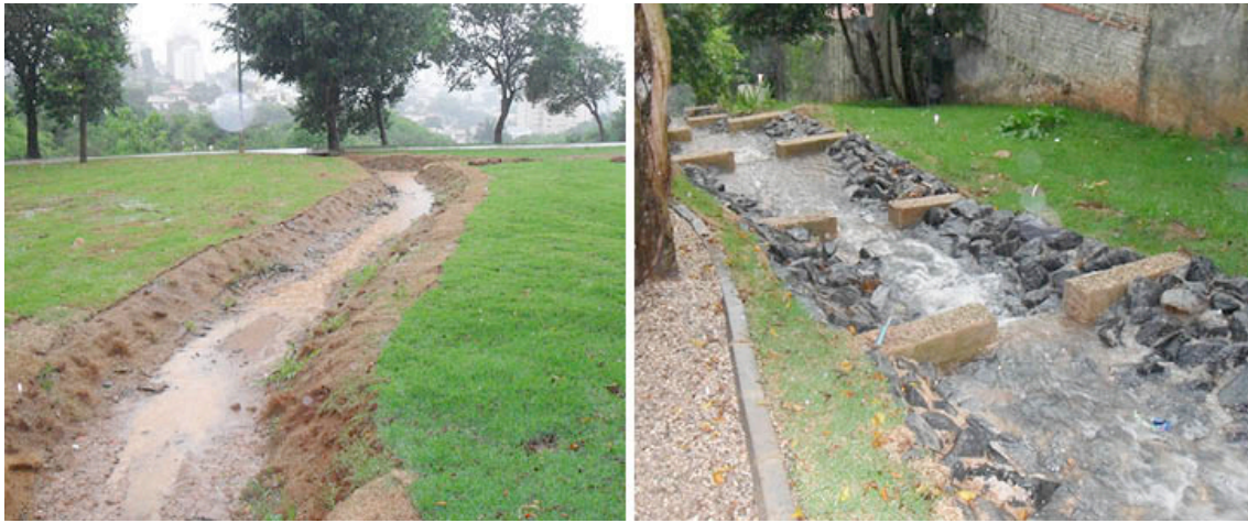
Figuras 12 e 13 – Biovaletas construídas na praça em dia de chuva. Fonte: Niero, Elza.
