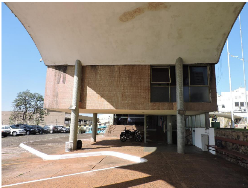
Figura 6 – Diferença de níveis da Rua Sergipe para plataforma de embarque, e escadaria de acesso. Fonte: Samantha Palma (2016).
